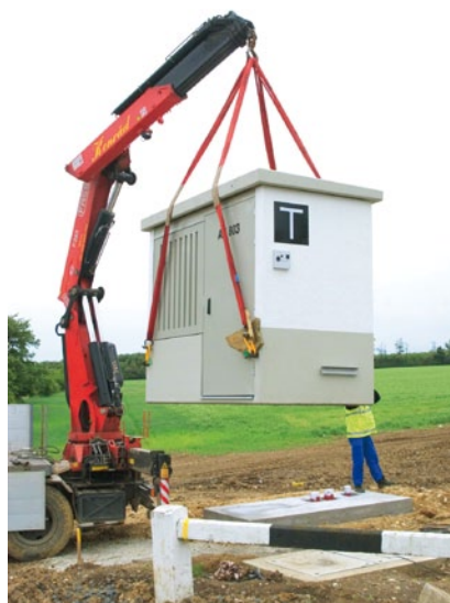
A berendezés telepítése
